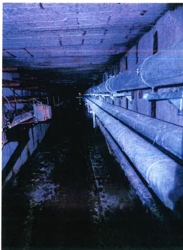
Widok kanału technologicznego
