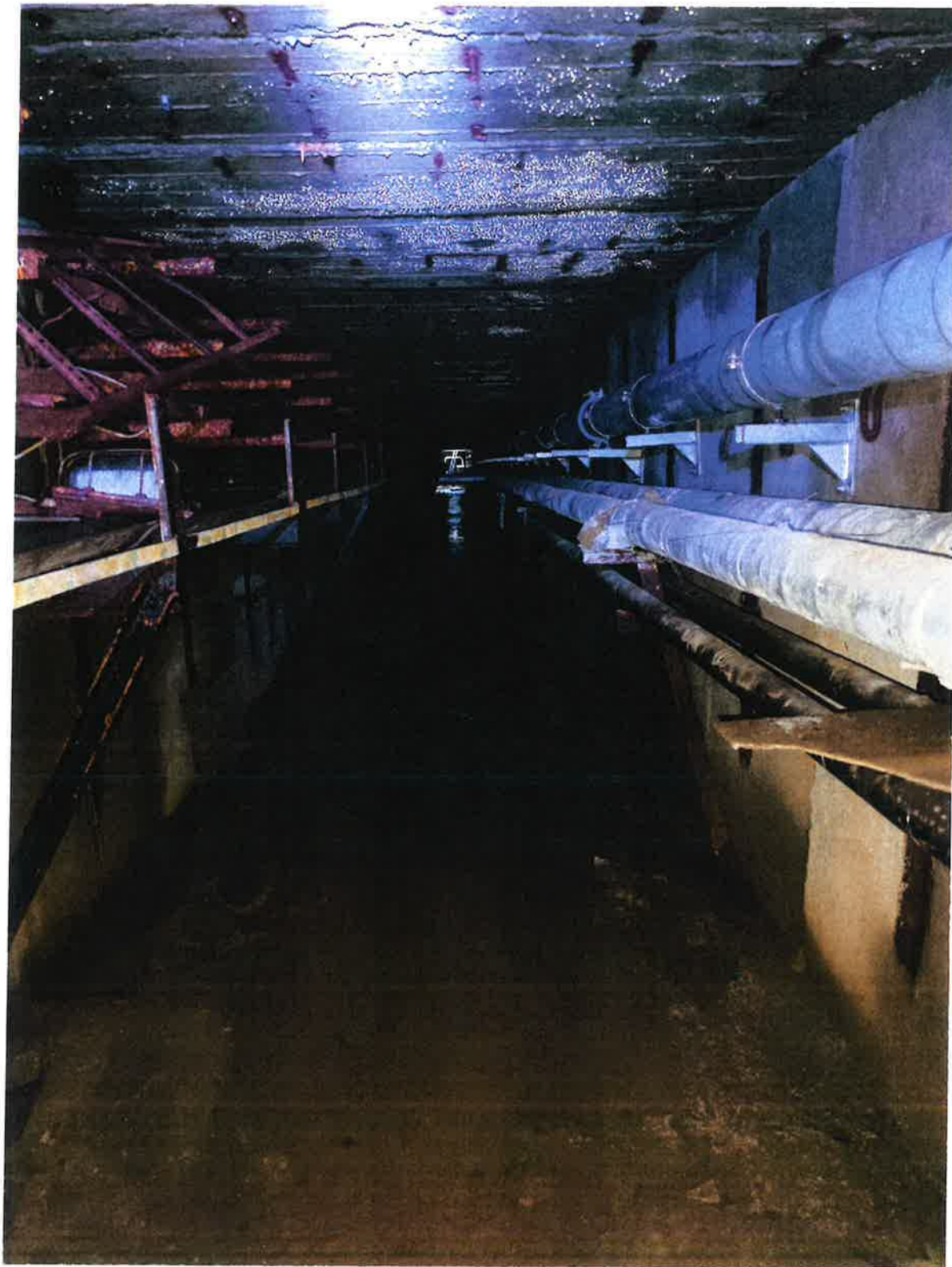
Widok kanału technologicznego
