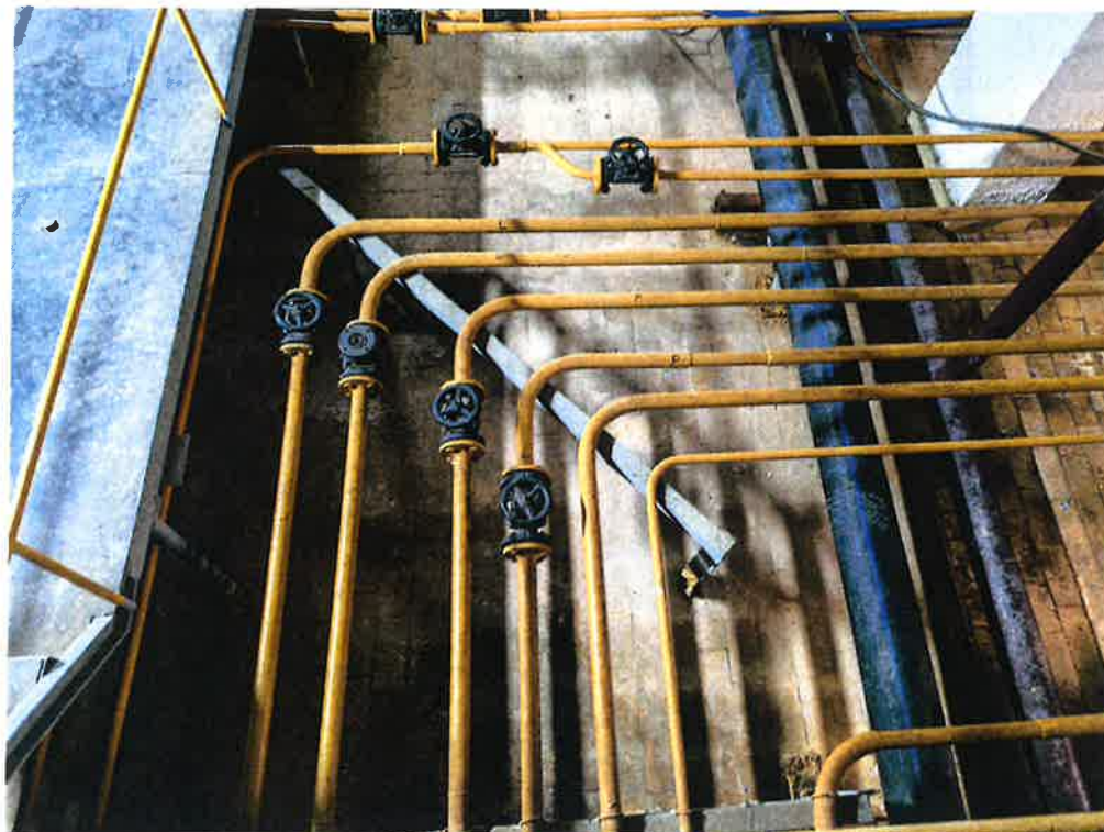
Widok istniejących rurociągów siarczanu glinu
