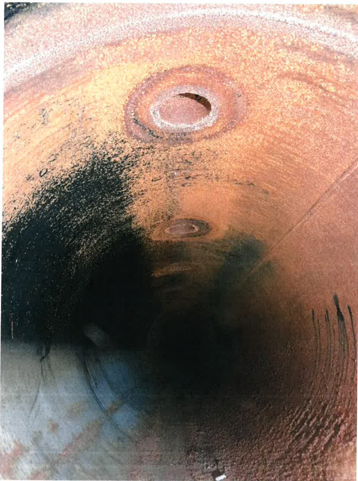
Widok wnętrza rurociągu DN1600 z odejściami pod zawory przeciwwuderzeniowe
