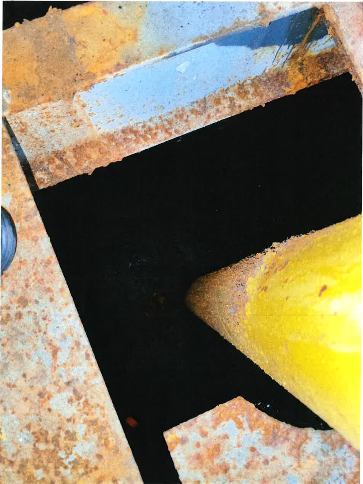
Widok króćca pionowego DN2000 odchodzącego od rurociągu DN1600
