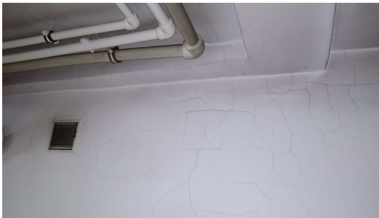
Fot. 7. Widoczne oparcie na ścianie działowej wymianów komina. Widoczne zarysowanie ściany.
